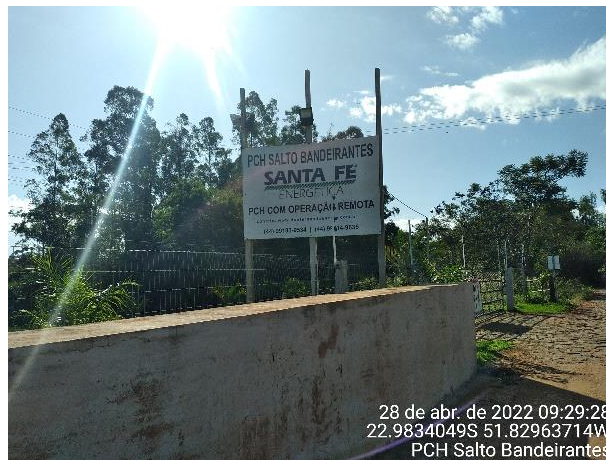
Figura 194 – Sinalização nas proximidades do canal de adução e acesso à casa de força.
