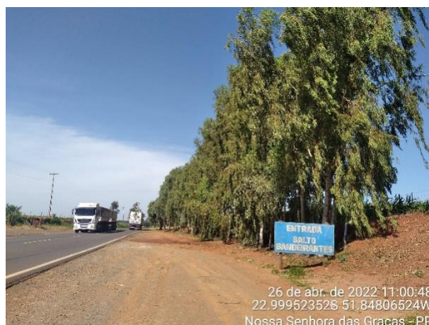
Figura 163 - PR-317 (sentido Santa Fé) nas proximidades da PCH Salto Bandeirantes.
