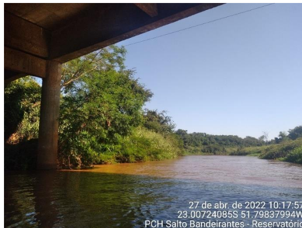
Figura 16 - Final reservatório PCH Salto Bandeirantes.
