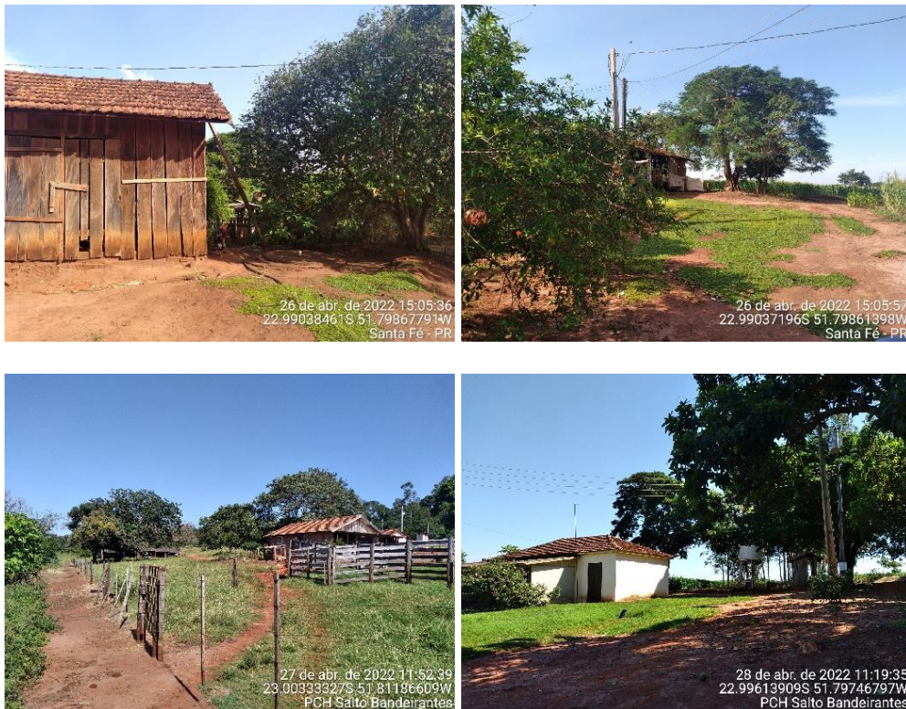
Figura 190 – Edificações nas propriedades da área de estudo.
